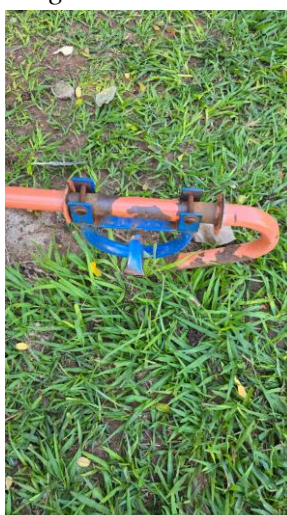
Foto 9 – Peça metálica quebrada no chão com parafusos enferrujados expostos
