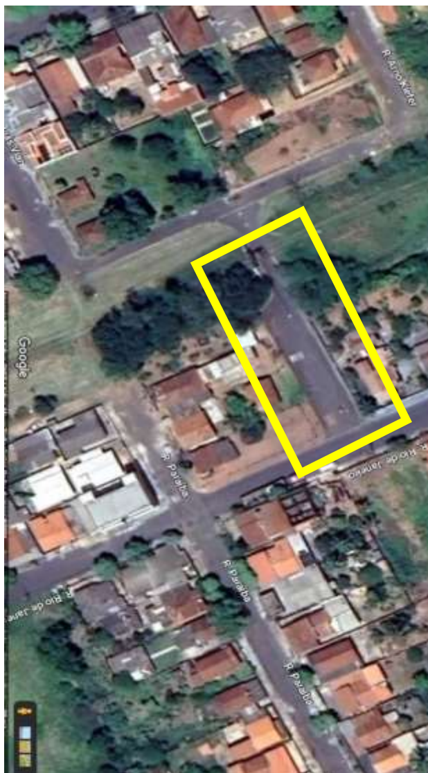
Figura 1 via pública com asfalto comprometido
