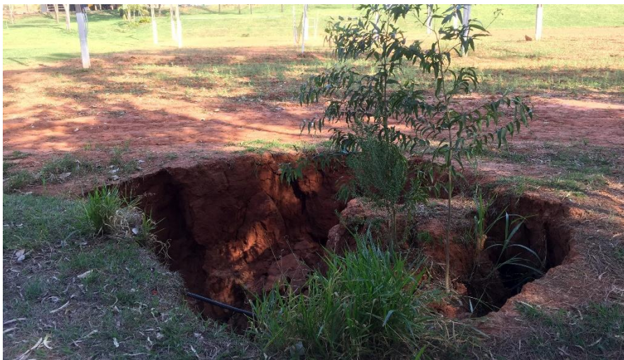
Buraco no Parque dos Pioneiros Região entre as quadras de areia e eucaliptos
