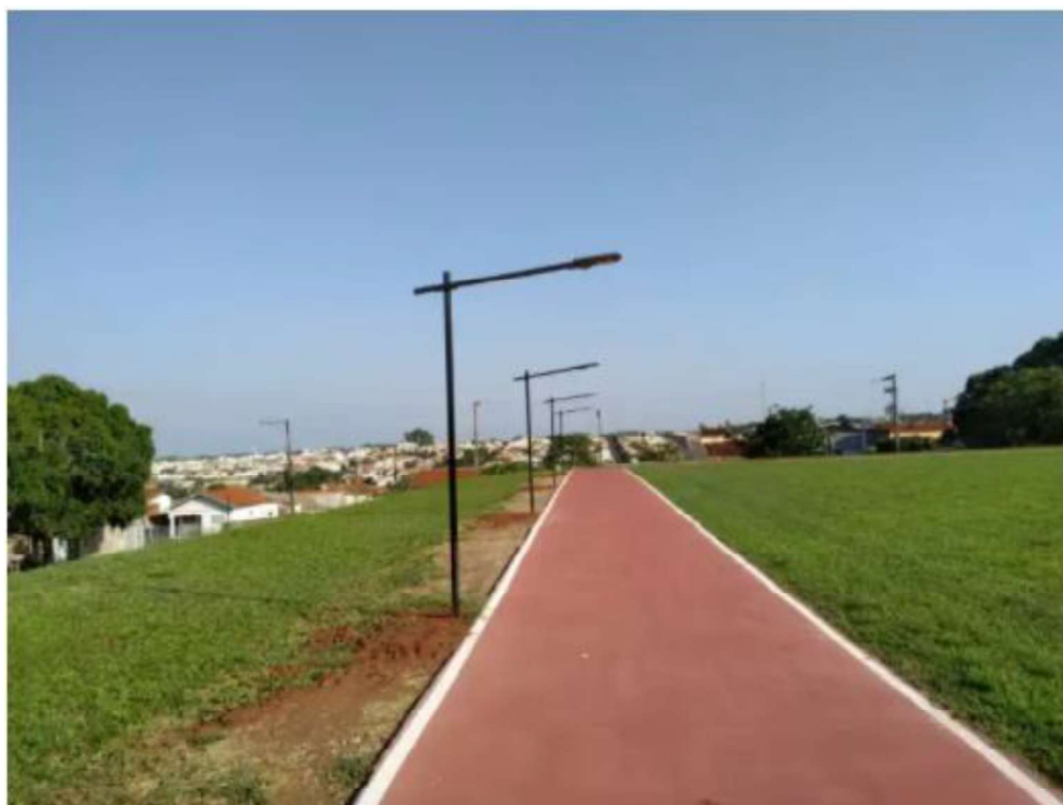
REGISTRO ATUAL DO CAMPO, QUE CONTA COM PISTA PARA CAMINHADA E ILUMINAÇÃO SUSTENTÁVEL
