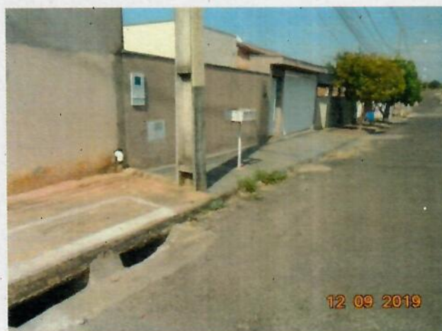
Foto 07 – Boca de lobo existente reformada e desobstruída na Rua Cedro, confluência com a Rua Pinheiro.
