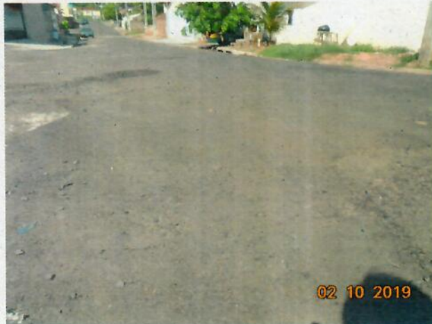
Foto 17 – Recomposição asfáltica na Rua Cedro, sobre galeria executada entre as bocas de lobo das Fotos 15 e 16.
