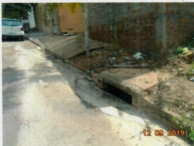
Foto 05 – Boca de Lobo simples existente na Rua Pinheiro.
