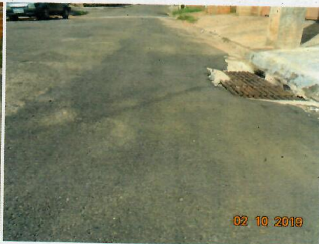
Foto 14 – Grelha executada junto à Boca de lobo dupla existente, e recomposição asfáltica da galeria executada na Rua Cedro.
