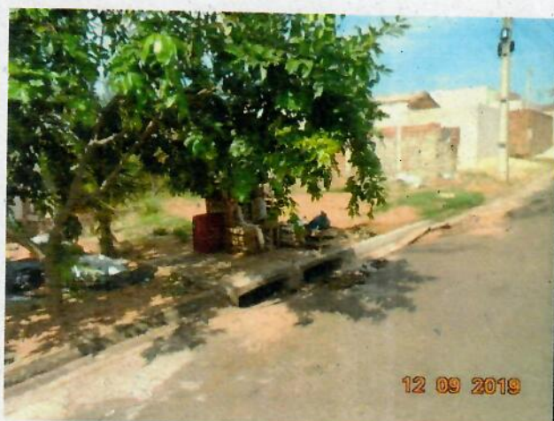
Foto 15 – Boca de lobo dupla existente reformada e desobstruída na Rua Cedro, confluência com a Rua Cabreúva.
