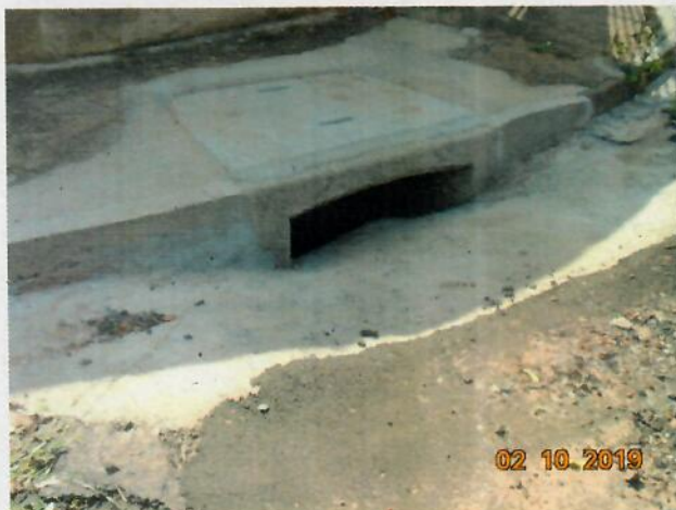
Foto 09 – Boca de Lobo simples executada ao lado direito da Rua Mogno.
