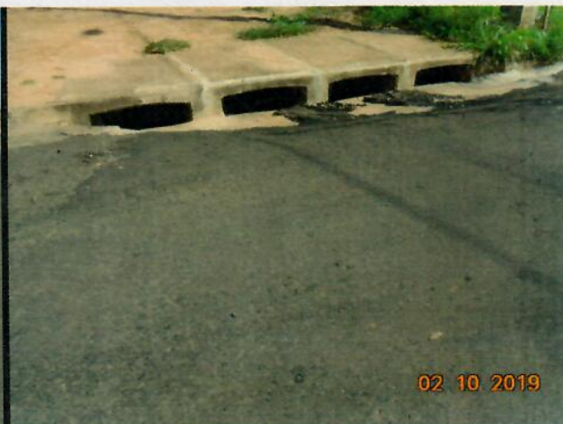
Foto 08 – Boca de lobo quádrupla existente com recomposição asfáltica sobre galeria executada (Rua Cedro confluência com a Rua Mogno).
