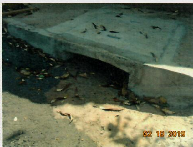
Foto 02 – Boca de lobo executada na Confluência entre a Rua Cambará e a Rua Cedro.
