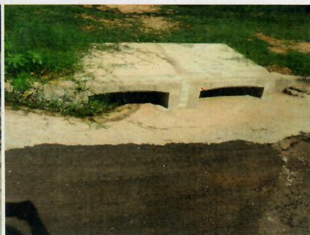
Foto 04 – Boca de lobo executada do outro lado na confluência entre a Rua Cambará e a Rua Cedro
