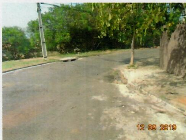
Foto 01 – Confluência entre a Rua Cambará e a Rua Cedro. Bocas de lobo executadas dos dois lados da rua
