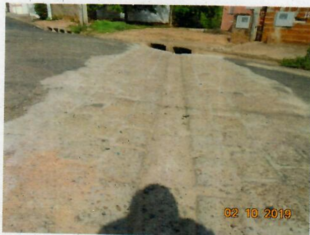
Foto 13 – Sarjetão executado, que direciona as águas pluviais para a Boca de lobo dupla existente na Rua Cedro.
