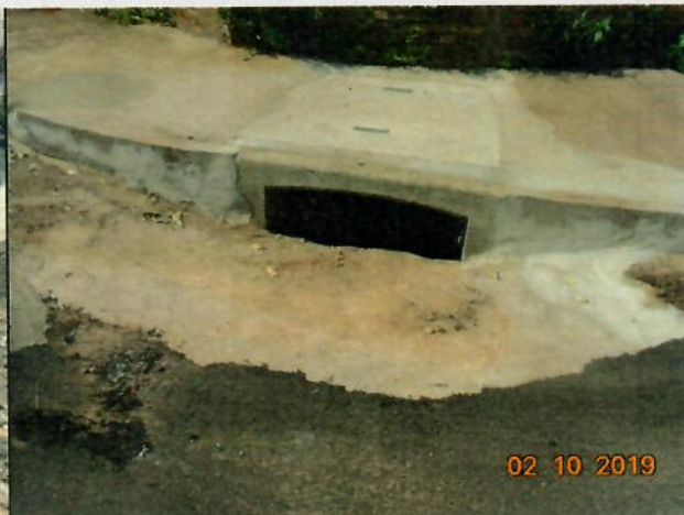
Foto 10 – Boca de Lobo simples executada ao lado esquerdo da Rua Mogno.
