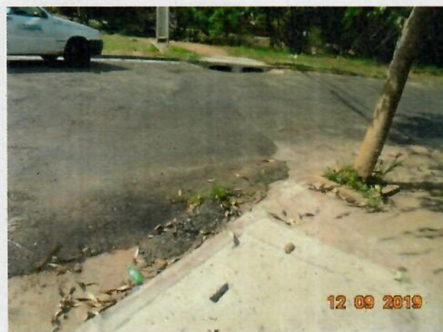
Foto 03 – Recomposição asfáltica sobre galeria executada na Confluência entre a Rua Cambará e a Rua Cedro
