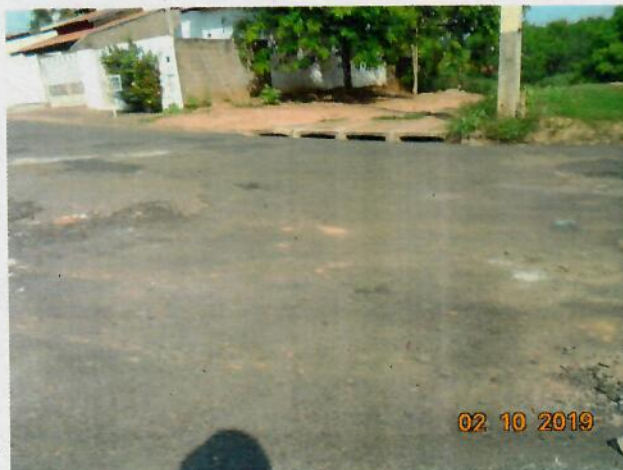
Foto 11 - Recomposição asfáltica sobre galeria executada na Confluência da Rua Mogno com a Rua Cedro.
