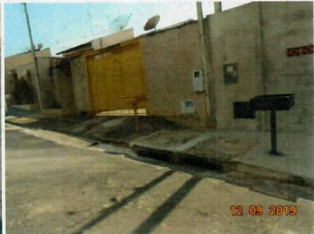
Foto 18 –Boca de lobo existente reformada e desobstruída na Rua Cabreúva.
